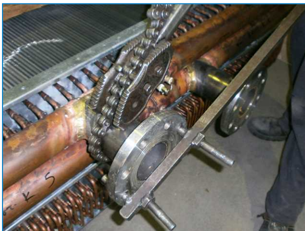
Instalace šroubové příruby
