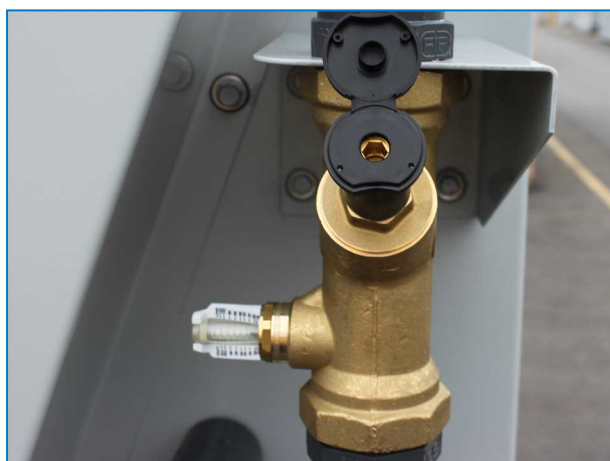
Šroub pro nastavování průtoku vody
