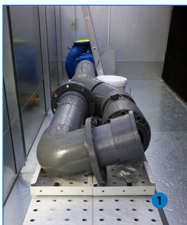
1. Vyměňte čerpadlo a potrubí z úseku vany.
