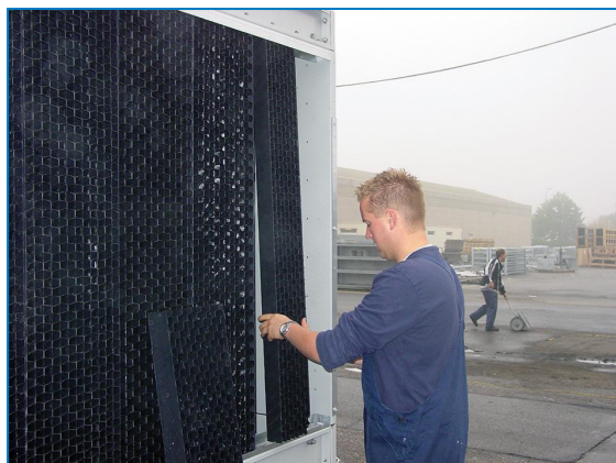
Demontáž kombinovaných krytů sání vzduchu
