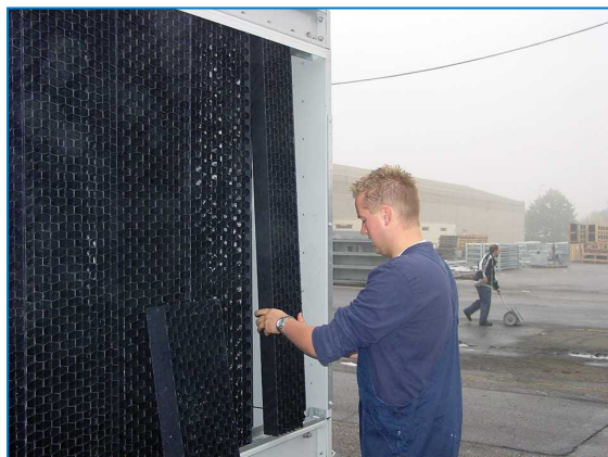
Demontáž kombinovaných krytů sání vzduchu
