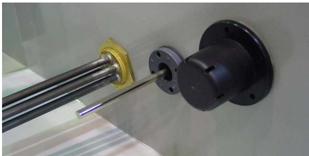
Ohříváč sběrné nádrže
