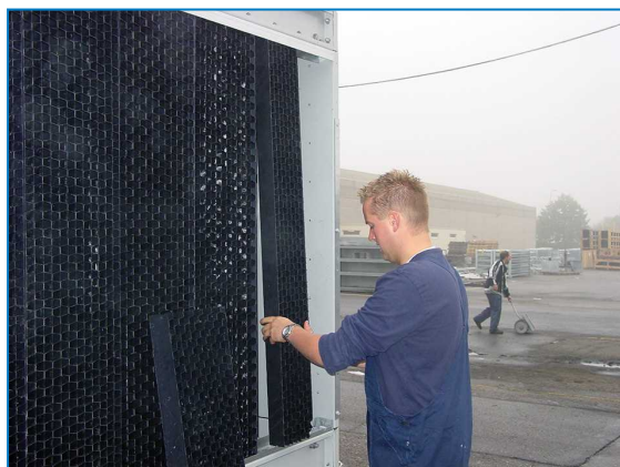
Demontáž kombinovaných krytů sání vzduchu
