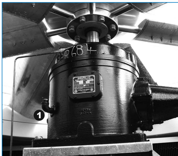
Jednostupňová redukční převodovka s ozubenými koly
