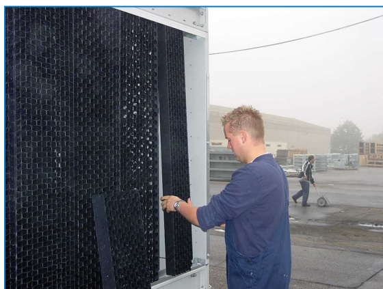
Demontáž kombinovaných krytů sání vzduchu
