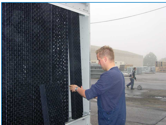
Demontáž kombinovaných krytů sání vzduchu
