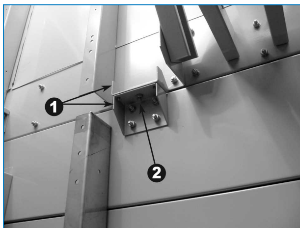
Komorová sekce nainstalovaná na spodní sekci
