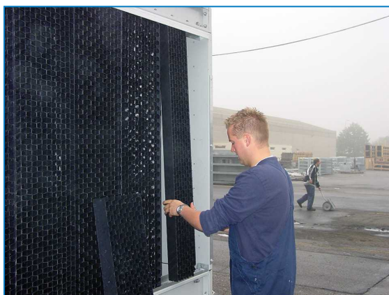
Demontáž kombinovaných krytů sání vzduchu
