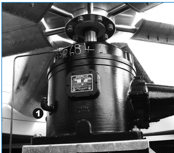
Jednostupňová redukční převodovka s ozubenými koly
