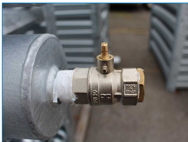
Horní připojení TVT s pojistným tlakovým ventilem na chladicích věžích s uzavřeným okruhem se spojí většími než ND100.
