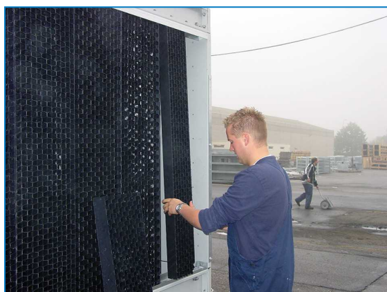
Demontáž kombinovaných krytů sání vzduchu
